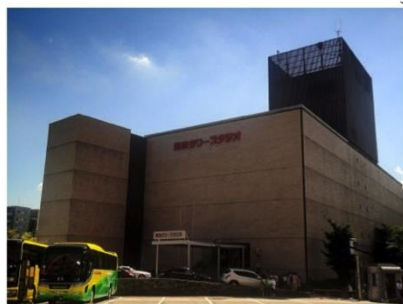
☆正面玄関の様子
