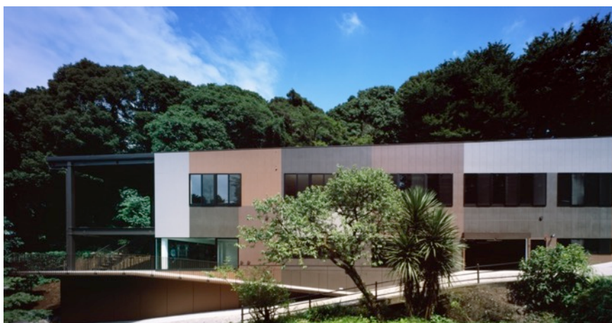
クレアーレ熱海ゆがわら工房の外観
