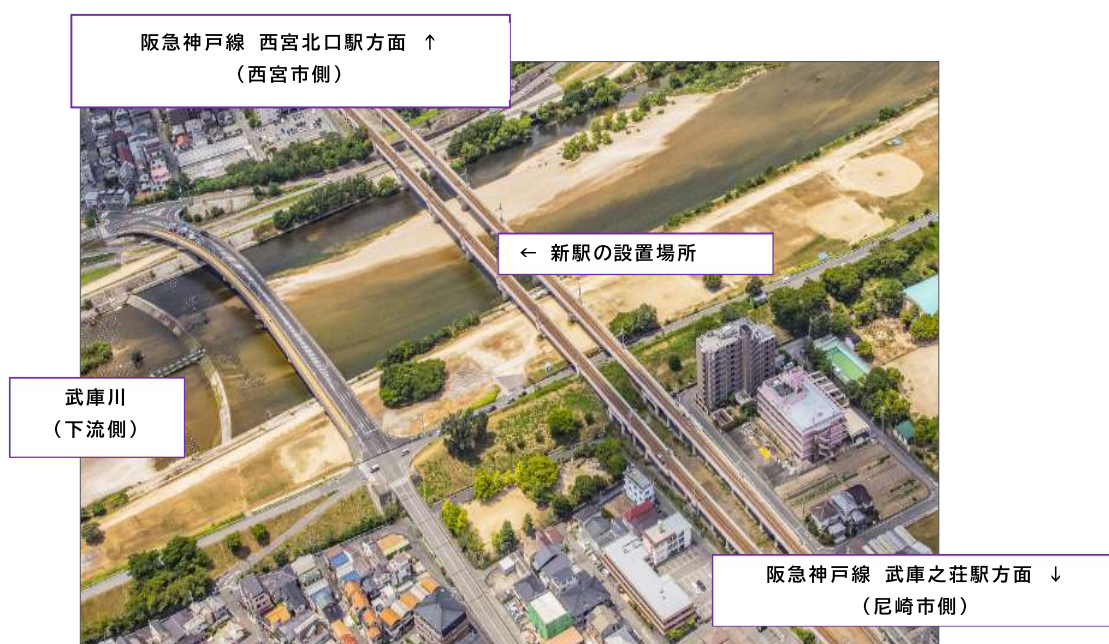
新駅設置場所となる武庫川橋梁付近
