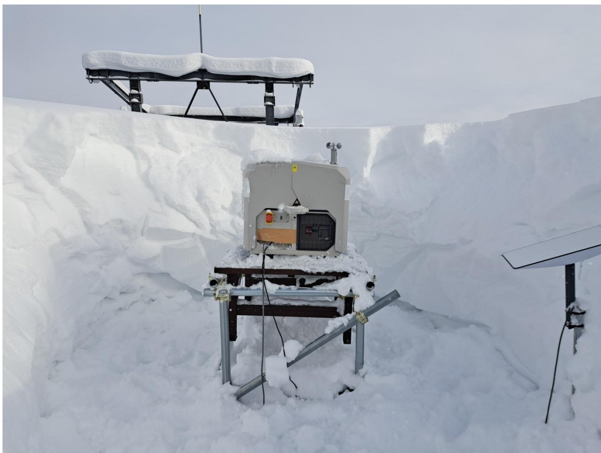
【写真 富良野スキー場のゴンドラ駅舎に設置した設置型ドローンポートと衛星通信アンテナ】
