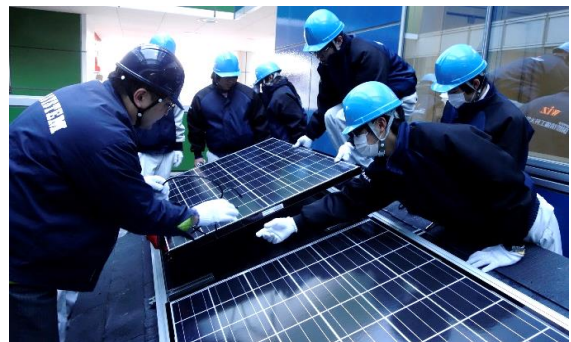
▲太陽光発電モジュールの取付
