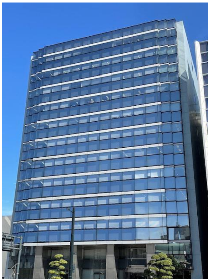
広島第一生命 OS ビルディング 6 階に、支店を開設
