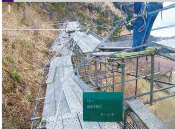
上部の水平ロープに柵高保持材を取り付けます。
