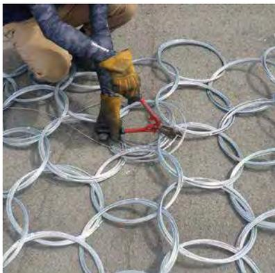
① 損傷したリングを取り外します。
