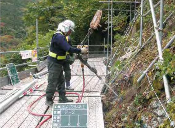
各アンカーの打設位置に、削岩機を用いて所定の角度で削孔します。
