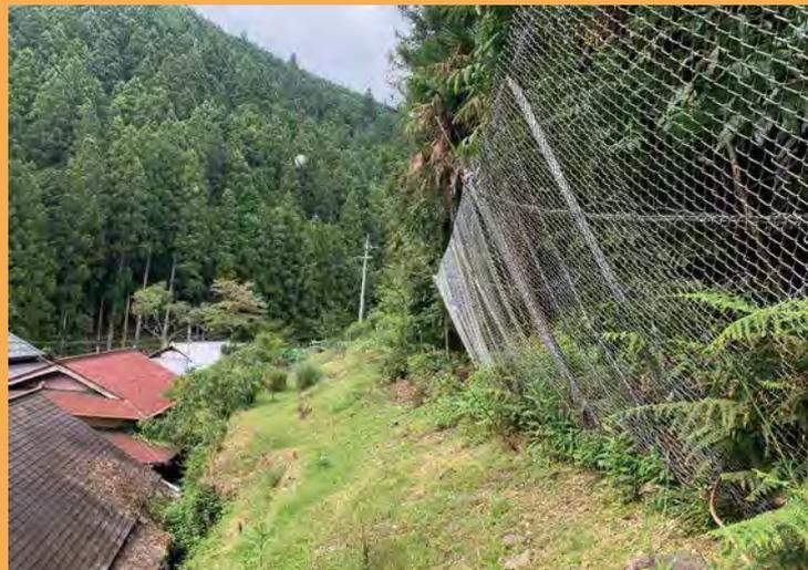
ARCフェンスは、主に斜面上に設置して道路や民家を落石から守る、落石防護柵です。金網、リングパネルの変形、およびワイヤロープと各所にバランス良く配置した緩衝装置の摩擦によって、落石エネルギーを吸収します。落石の規模に応じて6つのタイプがあり、最大1000kJまで対応可能です。
