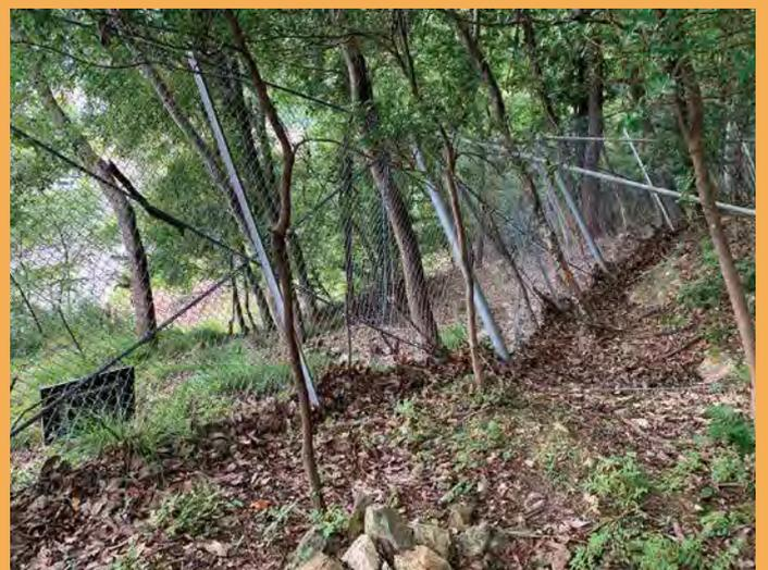
支柱間隔を地形に合わせて変えることができるため、立木を避けた設置が可能です。伐採を最小限に抑えられます。
