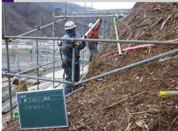
資機材の運搬を行い、作業用の足場を設置します。
