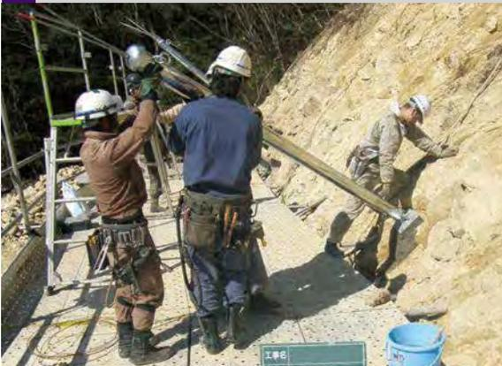
支柱内にワイヤロープを通し、支柱を建て込みます。ワイヤロープを緊張させ、支柱を自立させます。
