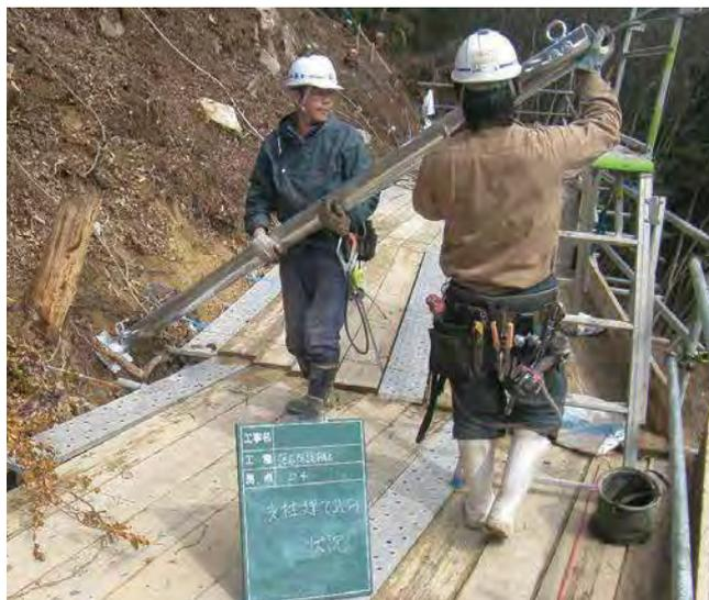
部材が軽量なため、人力施工・人肩運搬が可能です。最も重い部材である支柱でも人力で建込みが可能であり、道路から離れた現場でも問題なく施工ができます。
