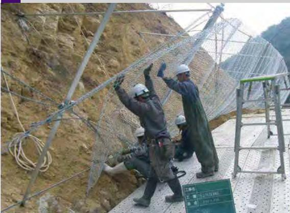
支柱谷側の面に、金網を設置します。金網は結合コイルで、ワイヤロープと結合します。
