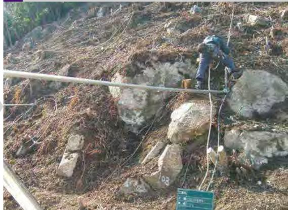
山側斜め控えロープを鋼管に通し、設置します。各支柱間には水平ロープと斜めロープを設置します。
