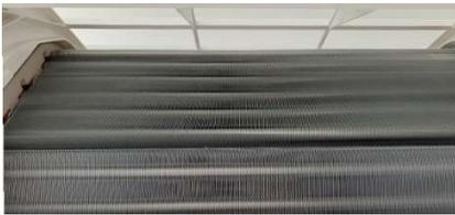
空気中に漂っているホコリは静電気を帯びていて、エアコンの熱交換器のフィンに付着します。AIRECO エアエコの装着後は、フィンが帯電しないためホコリが付きにくくなります。エアコン本来の熱交換効率を回復させ、消費電力を減らします。また、フィンにチリやホコリが付着することが防げるので、排出する空気もクリーンになります。
