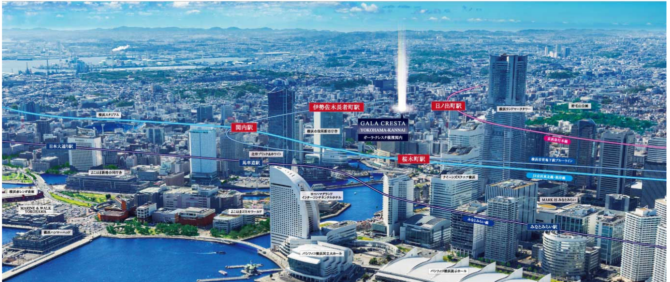
【現地上空からの航空写真】
