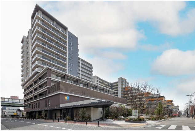
北東側の外観
