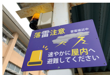
室内、室外で警報を呼びかける回転灯と案内板
