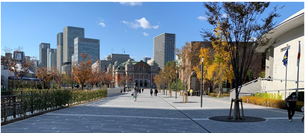
▲歩行者空間化工事が完了した中之島公園
