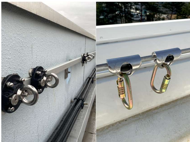
↑写真左がレールタイプ(アルミレール)☆/ 右がワイヤータイプ(ステンレスワイヤー)の親綱部分
