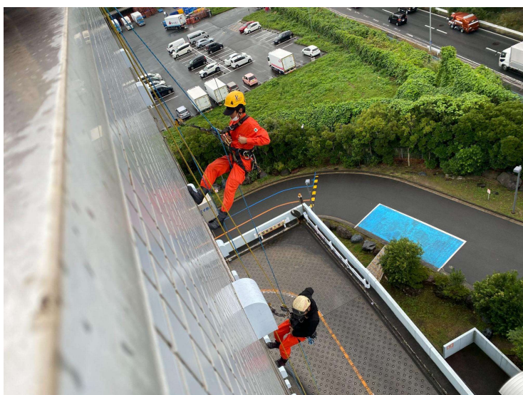
↑レールタイプを吊元にして ロープワーク作業を行っている様子☆
