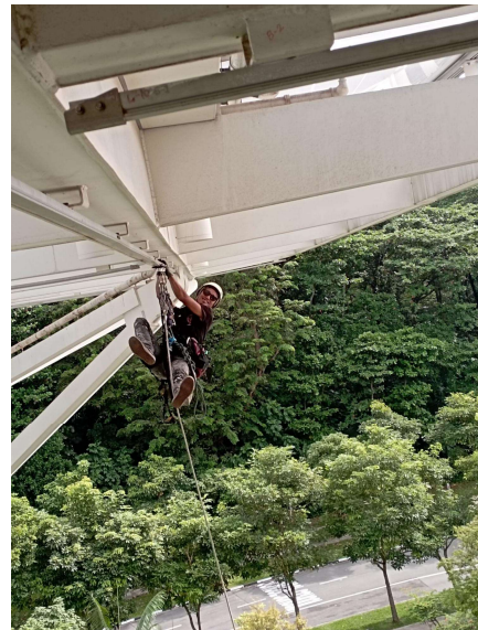
↑レールタイプを吊元としたロープワークでの外装点検に
