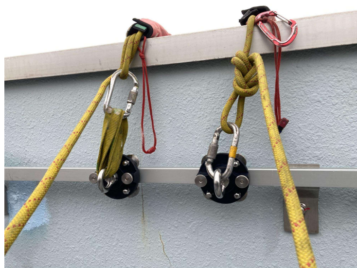
↑アルミレールに専用トローリーを用いて ロープワークの吊元に行っている様子☆
