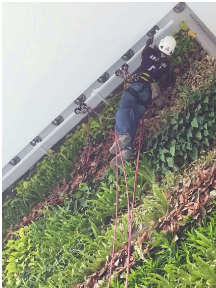
↑レールタイプを吊元としたロープワークでの外装点検に
