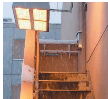
■ ビル・マンション非常階段
