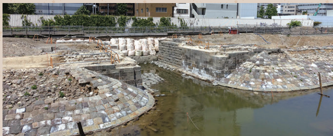
高輪築堤跡第7橋梁橋台部
