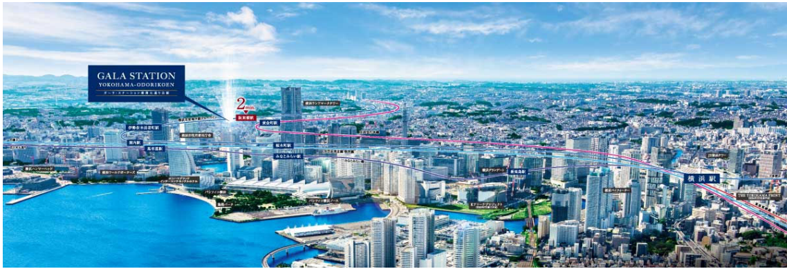
【現地上空からの航空写真】
