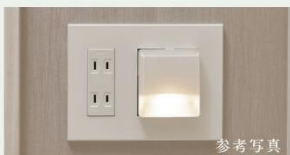
足元灯 廊下には足元灯を設置。停電時には自動点灯するなど、お子様にも安心な仕様です。
