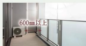
足掛かりの距離600mm以上 転落事故などを防ぐために、足掛かりとなるものを手摺りから600mm以上離しています。
