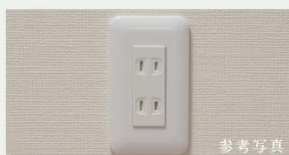
シャッター付きコンセント お子様の誤操作を防ぐよう、コンセントはシャッター付き。
