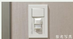
人感センサー付照明スイッチ 人を感知して自動的に点灯を行う、お子様にも安心の人感センサー付オートライトを設置。
