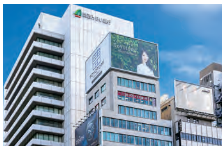
大阪市中央区西心斎橋 1-1-13 (心斎橋駅前)
