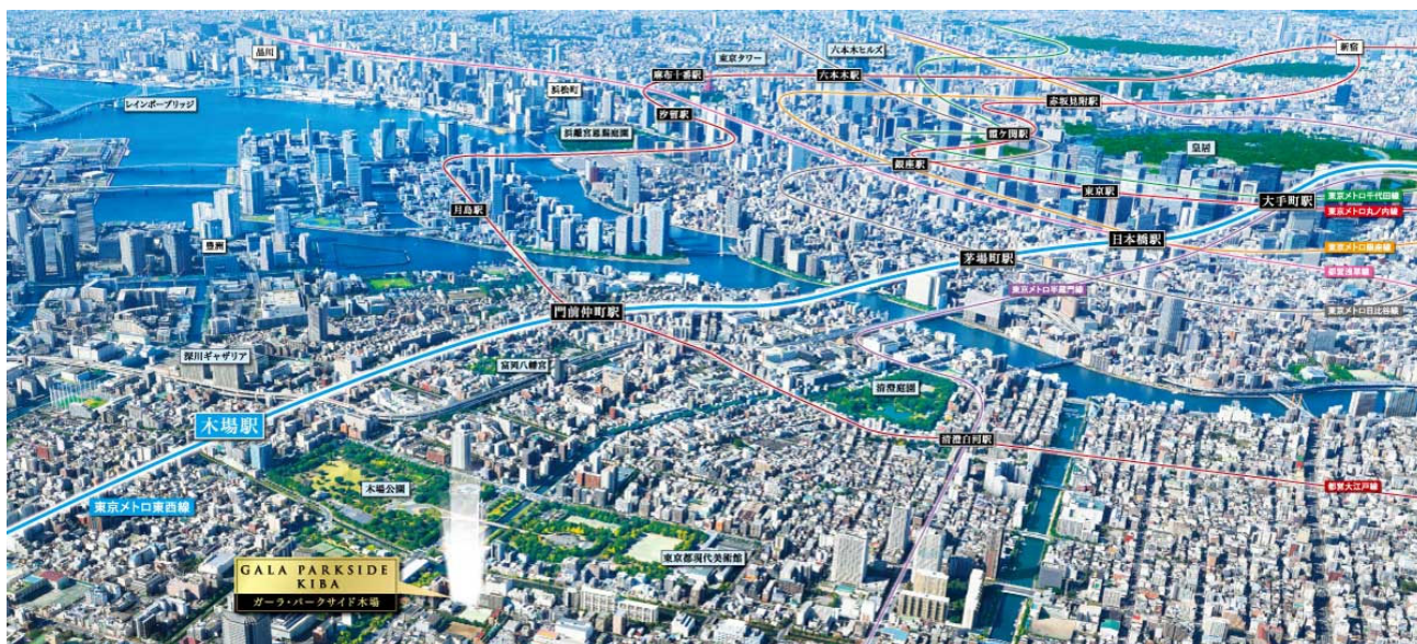
【現地上空からの航空写真】
