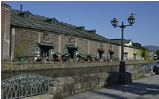
小樽運河 (小樽市)
