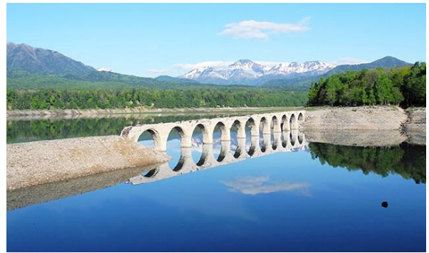
タウシュベツ川橋梁(上士幌町)
