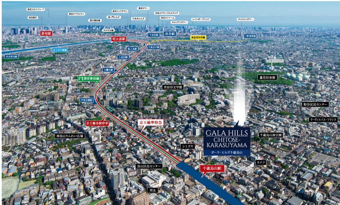
【現地上空からの航空写真】
