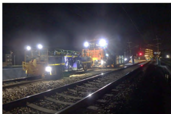
線路の保守作業の様子
