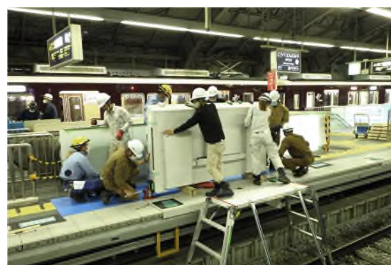
ホームドア設置の様子
