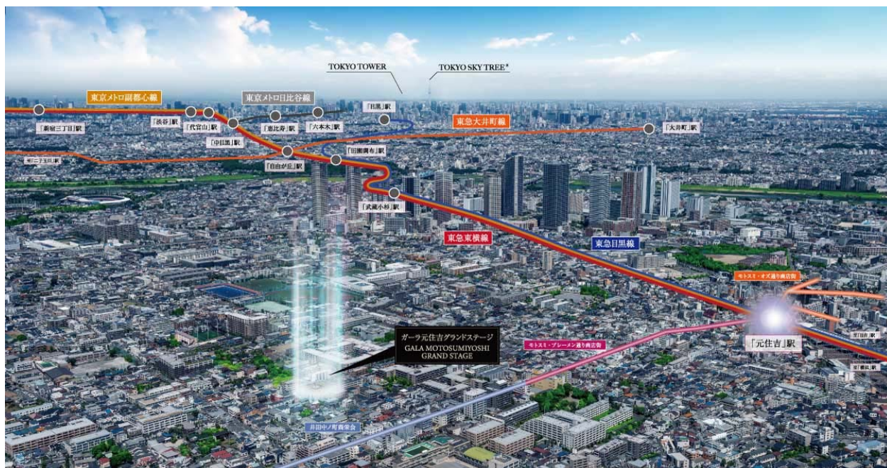
【現地上空からの航空写真】
