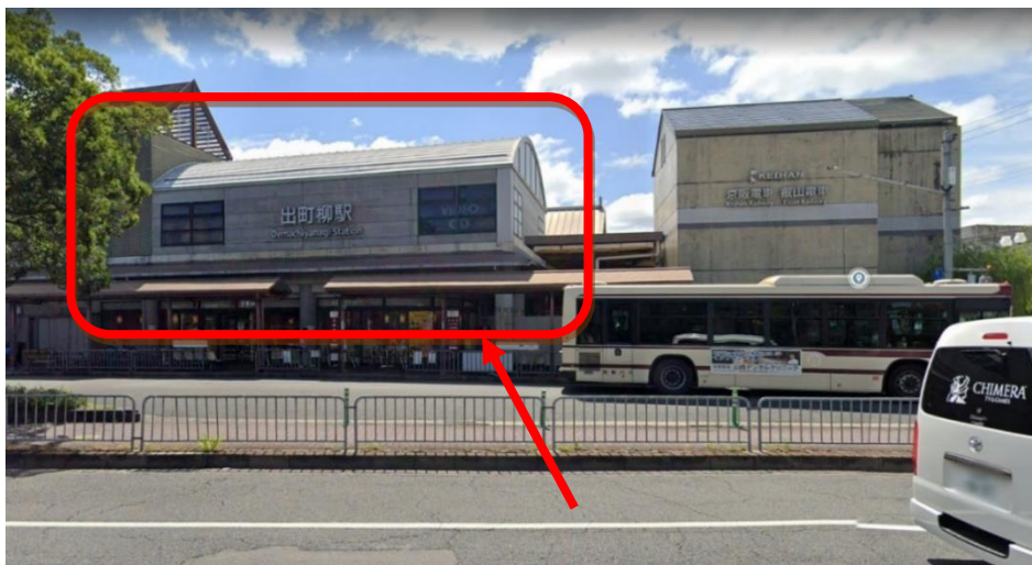
京阪出町柳ビル「外観」
