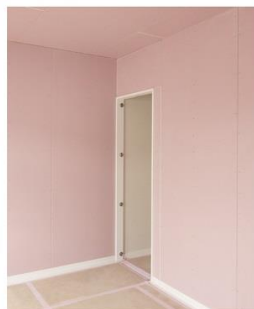
タイガーハイクリンボードの施工現場
