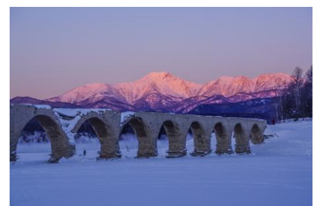
タウシュベツ川橋梁（上士幌町）
