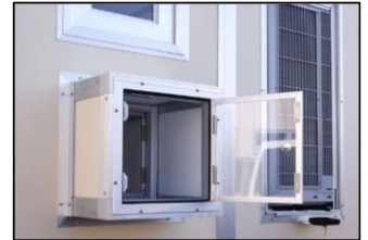
検体搬出用BOX窓
