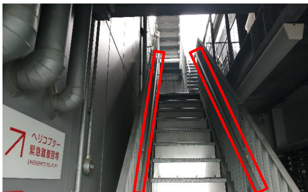
60階-ヘリポート 階段手すり
