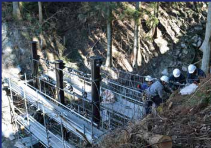
施工中のようす
