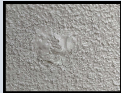
【従来のタッチアップ施工】
