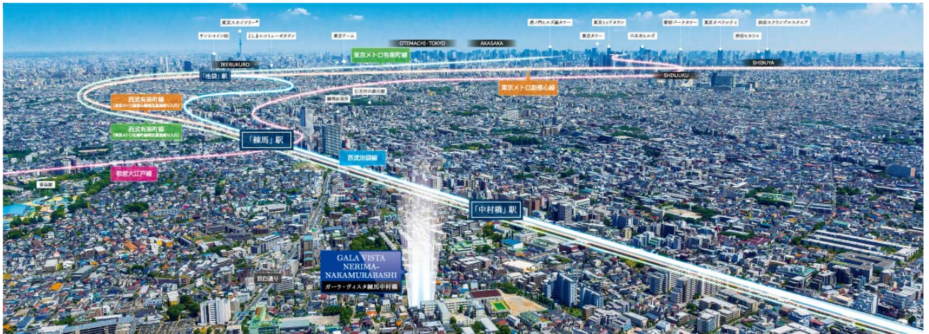
【現地上空からの航空写真】
