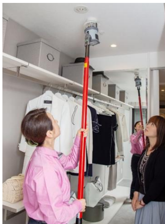
(点検作業イメージ)
