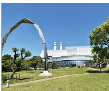
【麒麟ビール横浜工場】
