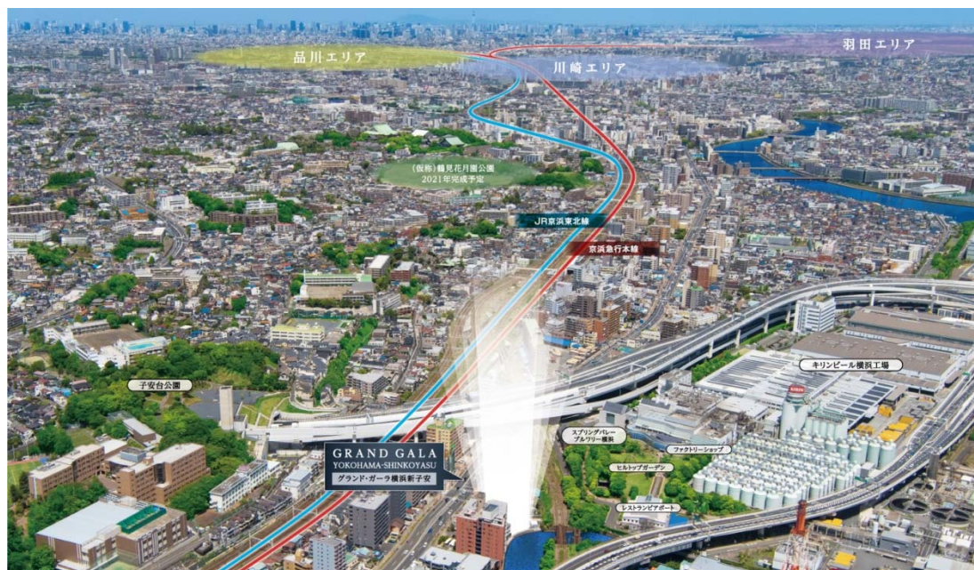
【現地上空からの航空写真】
