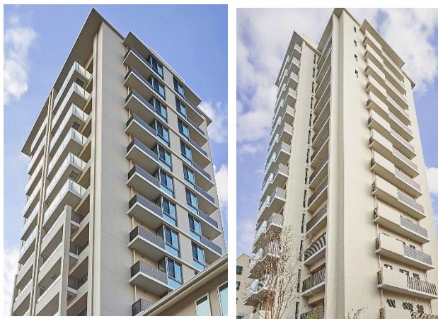
【左：南東面外観ディテール 右：北西面外観ディテール】
