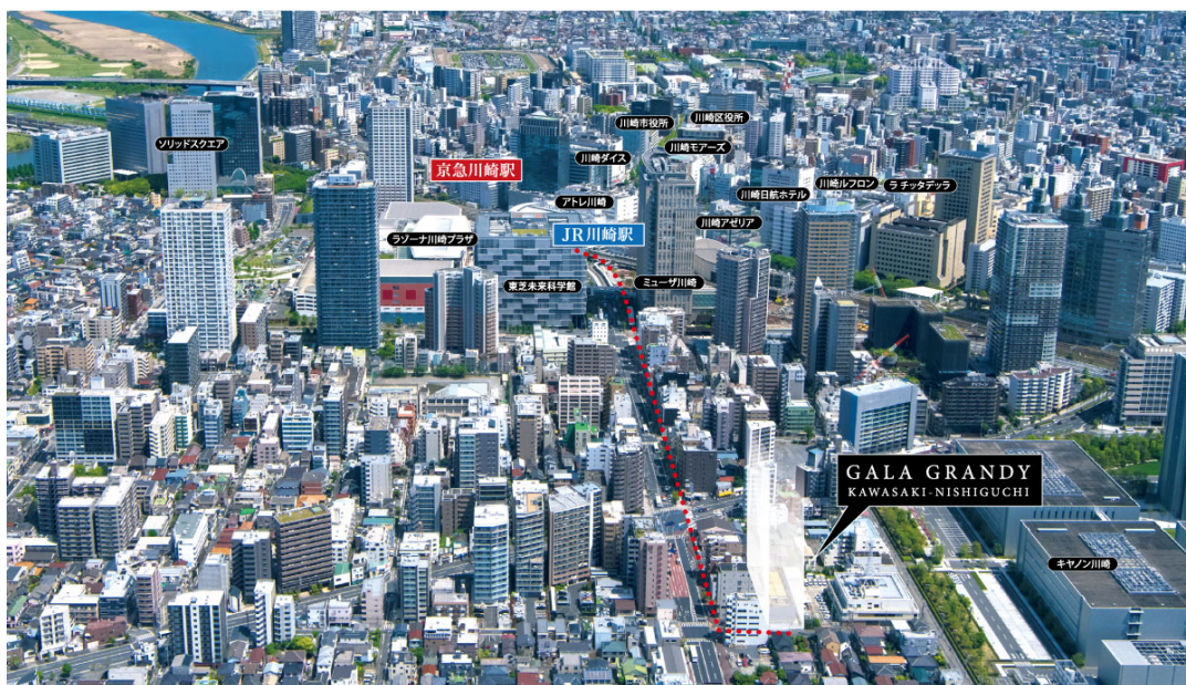
【現地上空からの航空写真】
