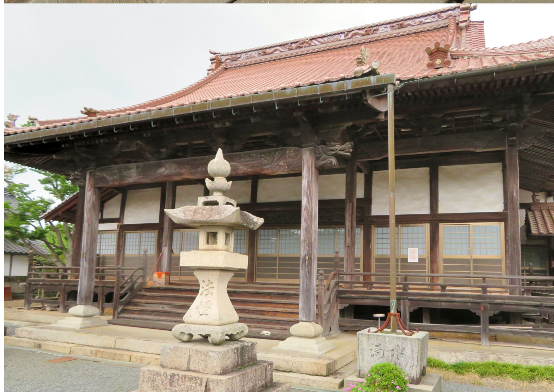
住職が本堂の 廊下を修理している
