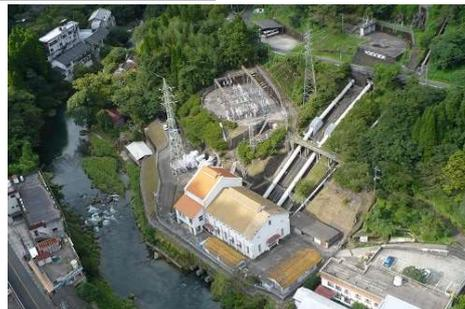
大正 10 年(1921 年)に中津川からの取水により 1 号機が運転を開始しました。江戸切仕上げの溶結凝灰岩を全体に積み上げた、大規模な石造建築物です。
