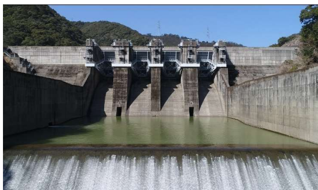
（石河内ダム全景）
