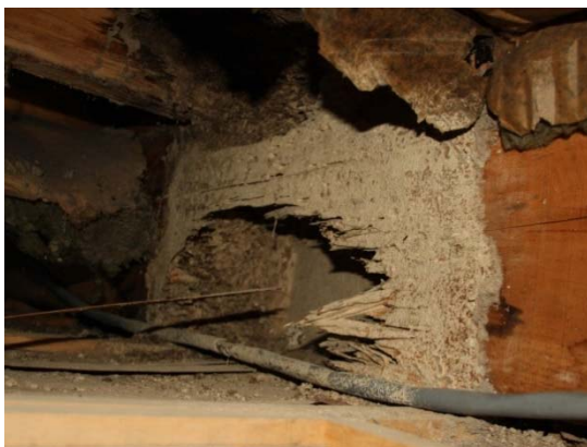
イエシロアリの被害にあった中天井（1階と2階のあいだの空間）の木材。イエシロアリの被害はとにかく激烈で広範囲に及ぶのが特徴。
