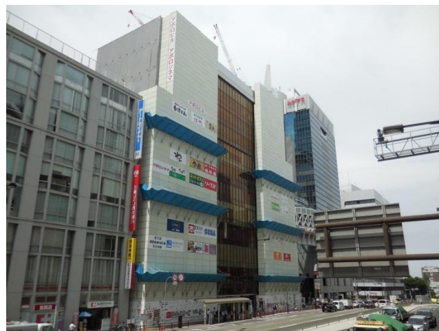
工事中のアポロビル
