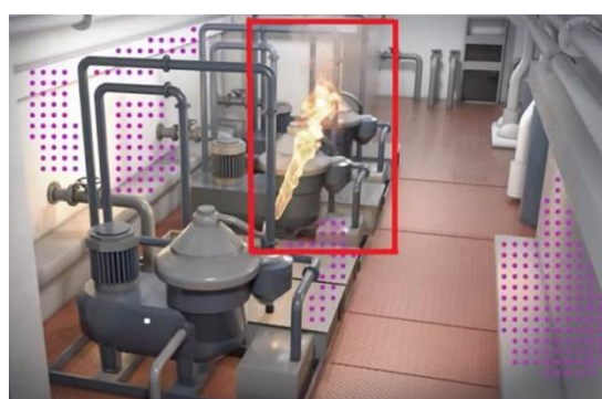
SigniFire 火災報知器が火炎を感知した様子
