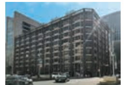
▶八重洲ダイビルの地下1階にあります。
