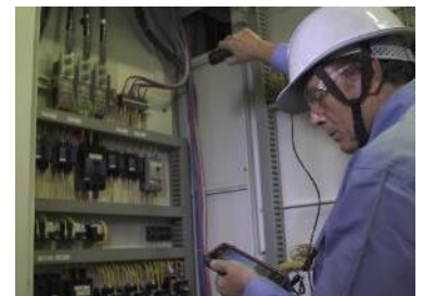
上から見下ろして測る
