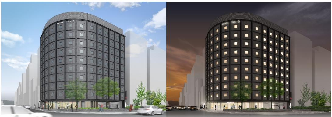
■外観デザインコンセプト “和-Wa” Contemporary:それぞれの部位に瓦屋根、井桁格子、市松文様、障子、漆喰塗、軒庇などの「和」のデザイン要素を、現代の素材、工法を用いて部位ごとに意味を持たせて配置。
