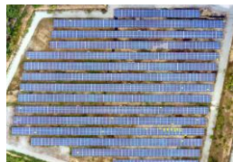
太陽光パネル
