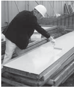
① 型枠に凝結遅延剤を塗布
