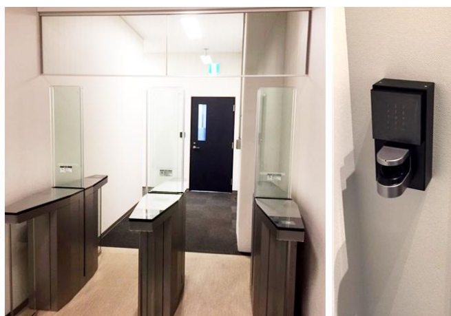
各種セキュリティ設備を導入 （左：フラッパーゲート、右：静脈認証）
