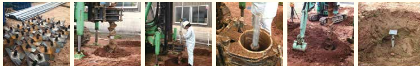
先端翼 先端翼取り付け 細径鋼管の挿入 細径鋼管挿入後 周辺地盤の締め固め 打設終了
