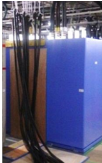
▲ 某データセンター・UPS（無停電電源装置）の能力検証
