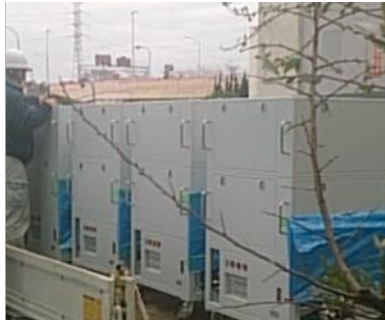
▲ 某IC・低圧発電設備の能力検証
