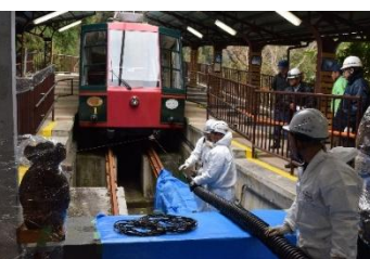
車両後部に新しいロープを接続し、離合箇所まで運転
